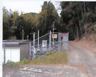
②沈砂施設 取水された水は、沈砂地で土砂やゴミなどが取り除かれています。
