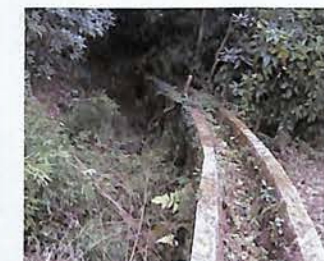
⑩旧導水路跡 第2サイホンより、丘陵西斜面に幅2~3mの旧導水路が残っています。
