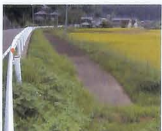
⑥道路西の導水路 道路西側に本管が通り、現在は蓋が被せられています。
