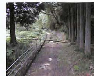
⑪第2サイホンより南の導水路 現在の本管でコンクリートで蓋がされています。
