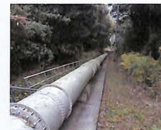
⑭水圧鉄管 ヘッドタンクより鉄管により落差175m下の発電所へ落とされます。
