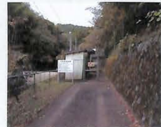
①城原川取水施設 城原川より毎秒1.8トンが取水され発電所に送られています。
