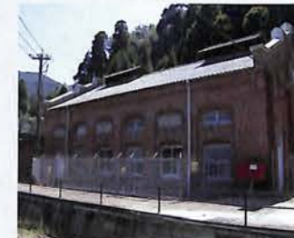
⑮広滝水力発電所 明治41年に竣工した煉瓦造りの発電所で、現在も稼働しています。
