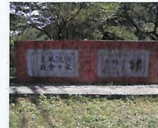
⑯石製扁額(記念碑) 峠のトンネル構造物に掲げられていた扁額です。右:入口・左:出口
