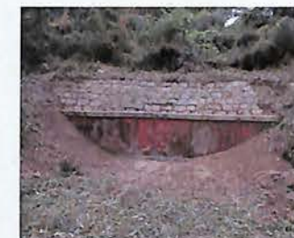
⑬草富峠南のトンネル出口施設 トンネルの導水路出口に作られた石垣と煉瓦積み構造物です。
