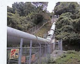
⑨勝陣橋下第2サイホン施設 約10mの高低差を利用し、対岸に水を送っています。
