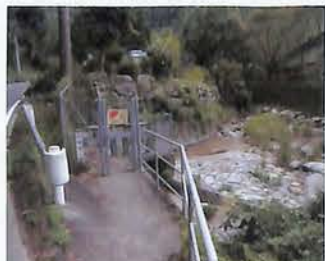
④白木川取水施設 白木川より毎秒0.14トンが取水され本管に合流しています。
