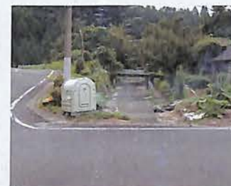
⑧第2サイホンに至る導水路 切通状の導水路で奥にサイホン施設があります。
