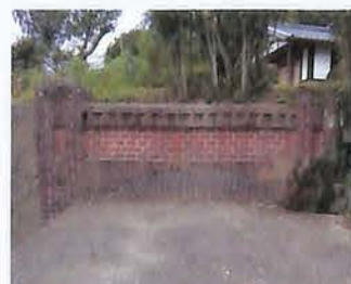
⑦導水路トンネル煉瓦構造物 トンネル構造の導水路の出口に設けられている構造物です。
